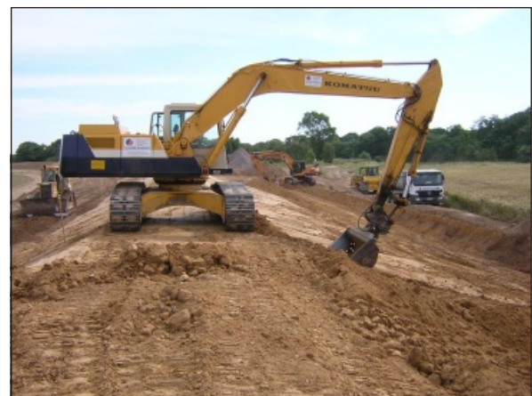
Deichkörperprofilierung nördlich von Raguhn
